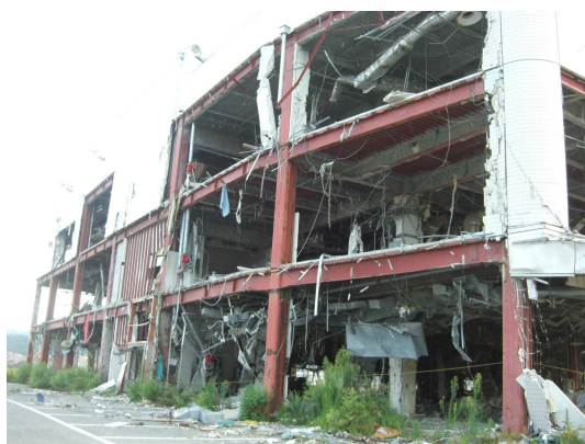
骨組みを残して全壊した市街地の建物 (市街地は鉄筋の建物以外は全て流されました。)
